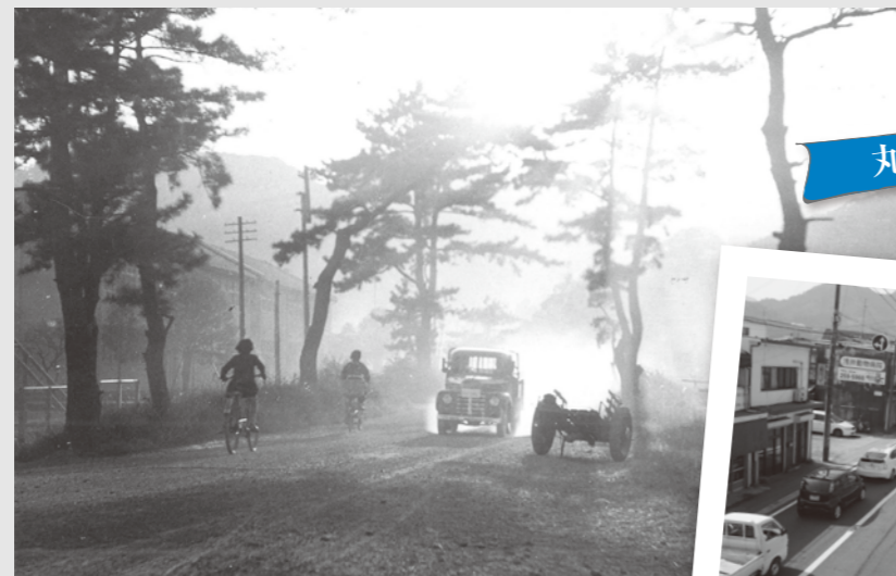
未舗装だった国道は車が通ると土ぼこりが舞い上がった (昭和29年、撮影:海野幸正)
