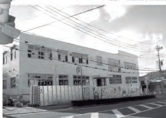
建設中の有度生涯学習交流館
