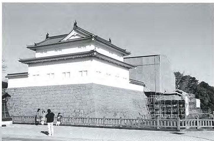
駿府城巽櫓と建設が進む東御門
