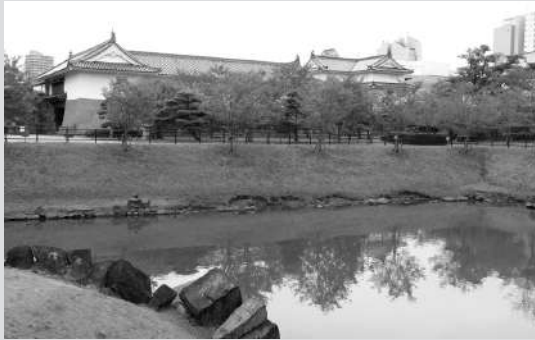
駿府城の本丸堀と東御門・翼櫓(駿府城公園内)
